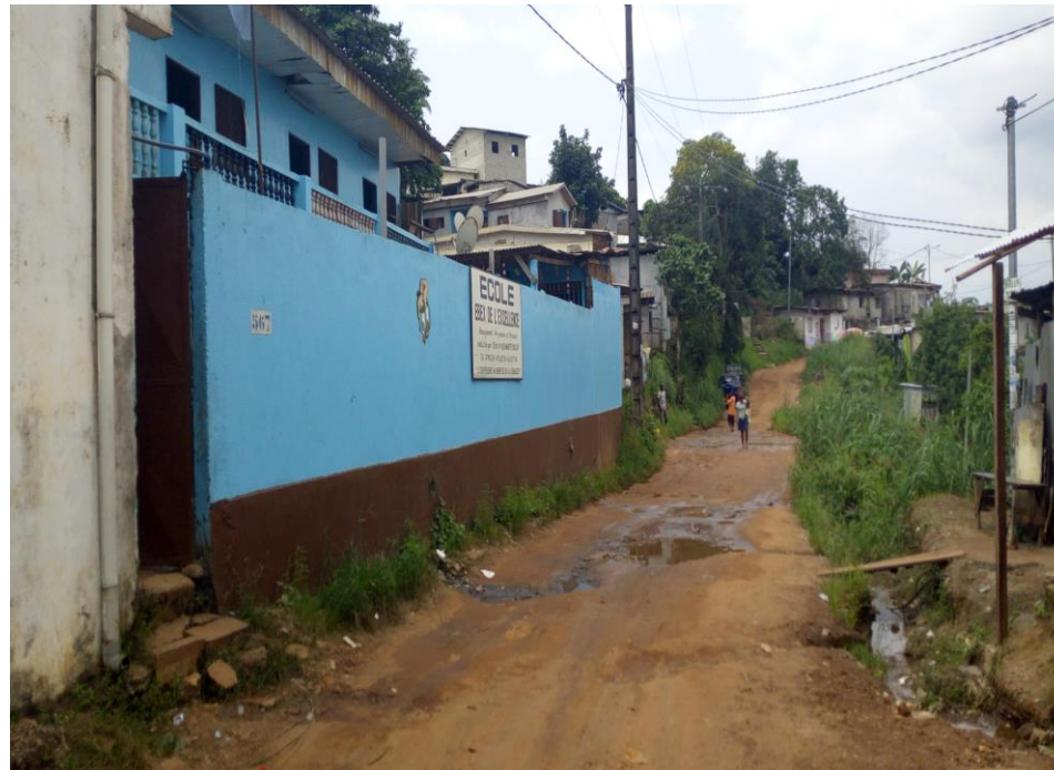
Etat des lieux avant Travaux
