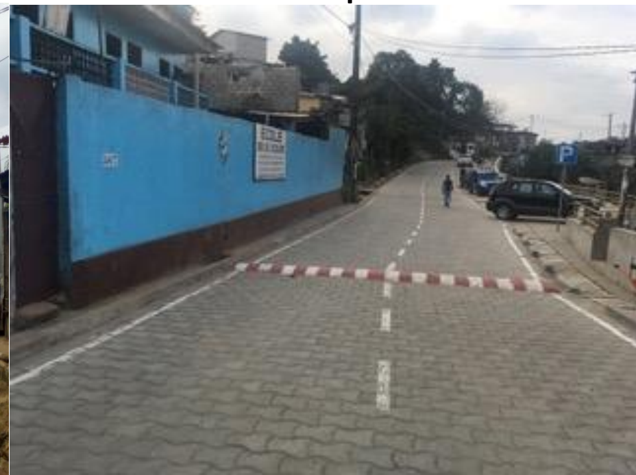
Etat des lieux après Travaux
