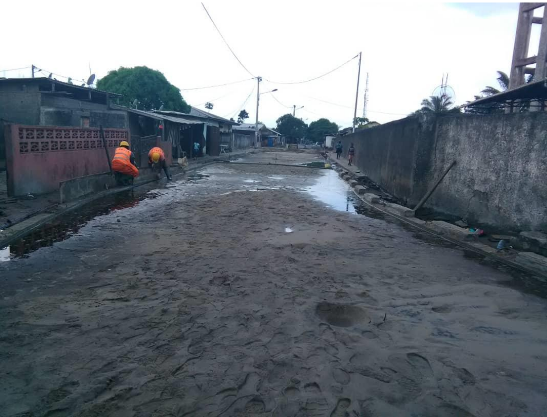
Etat des lieux avant Travaux
