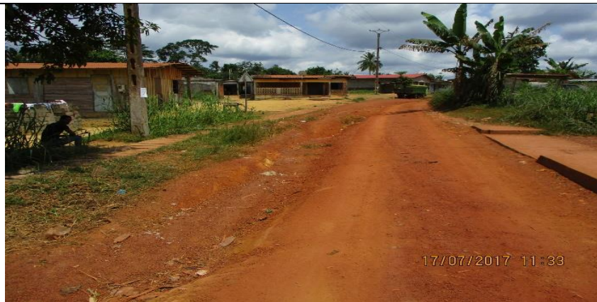
Etat des lieux avant travaux
