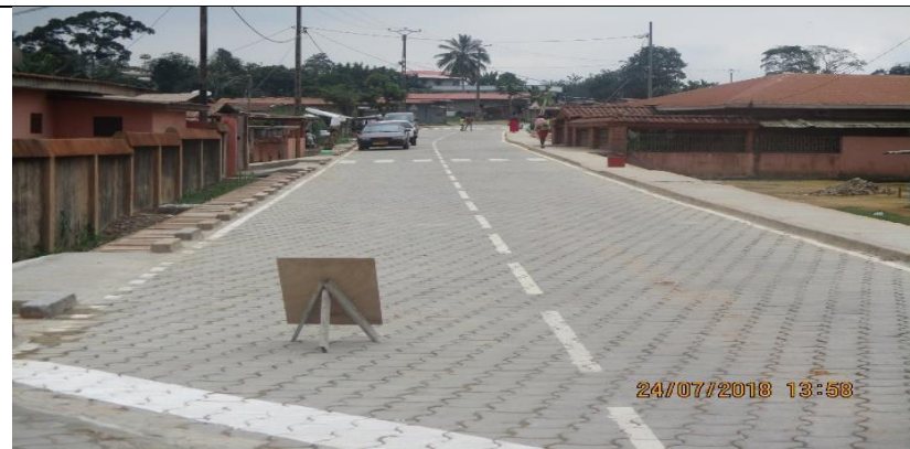
Etat des lieux après travaux
