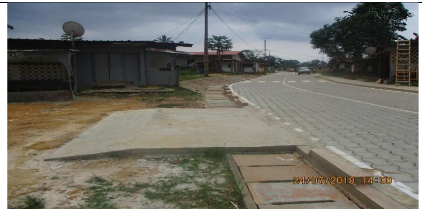
Etat des lieux après travaux
