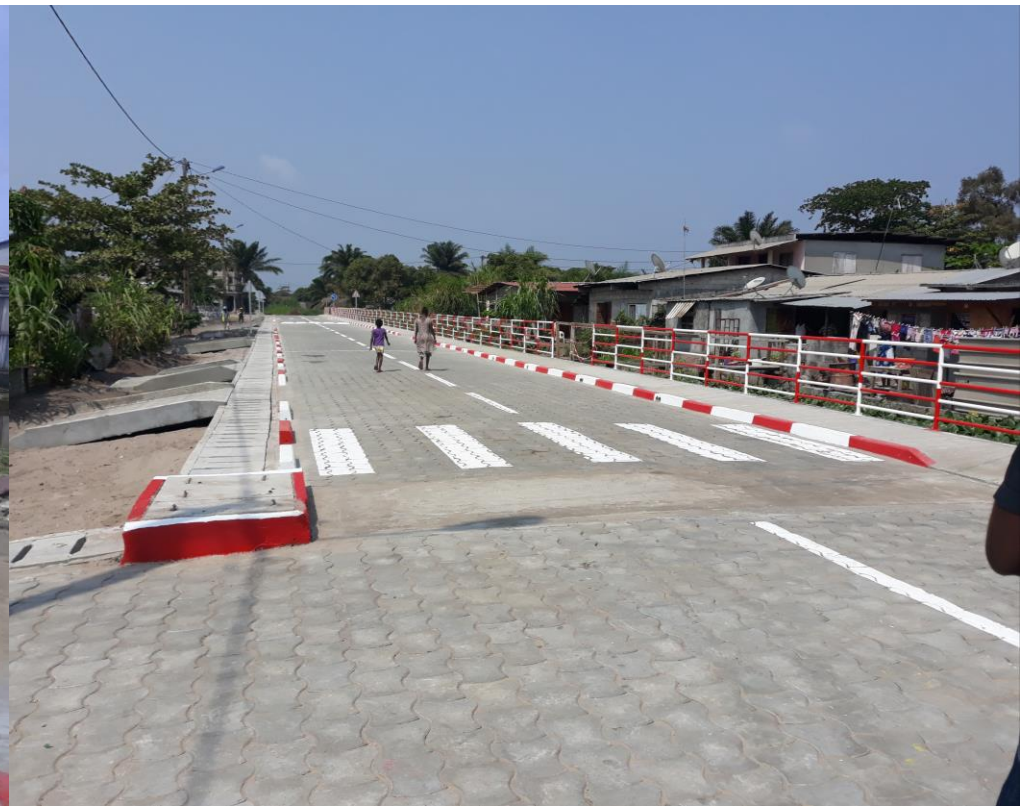
Etat des lieux après Travaux
