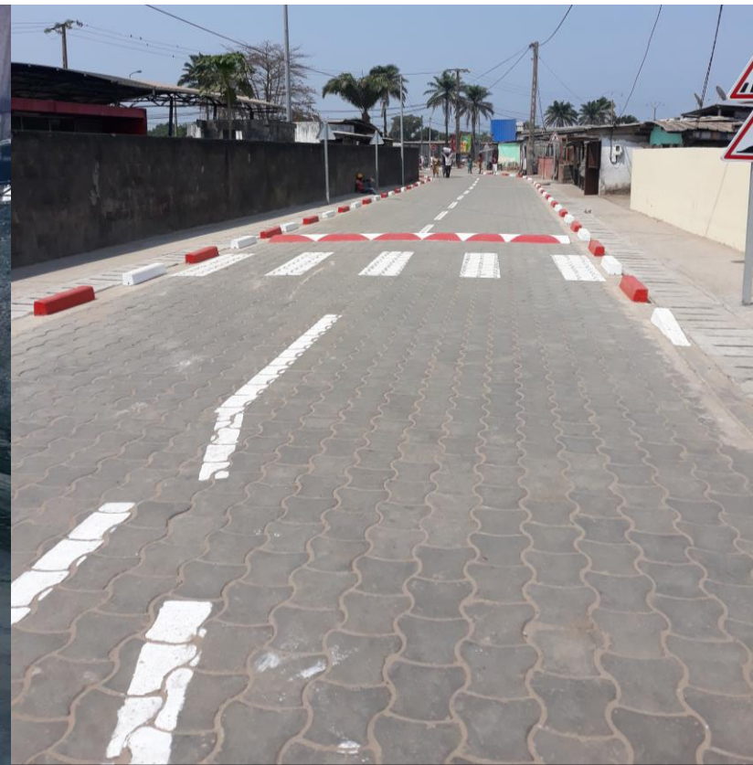
Etat des lieux après Travaux
