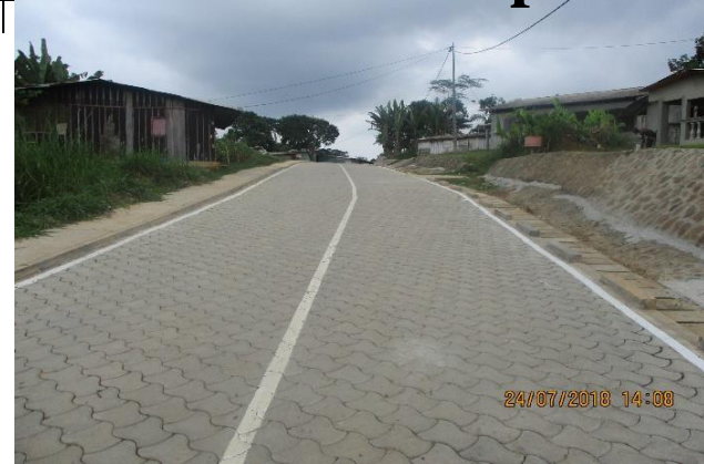
Etat des lieux après travaux
