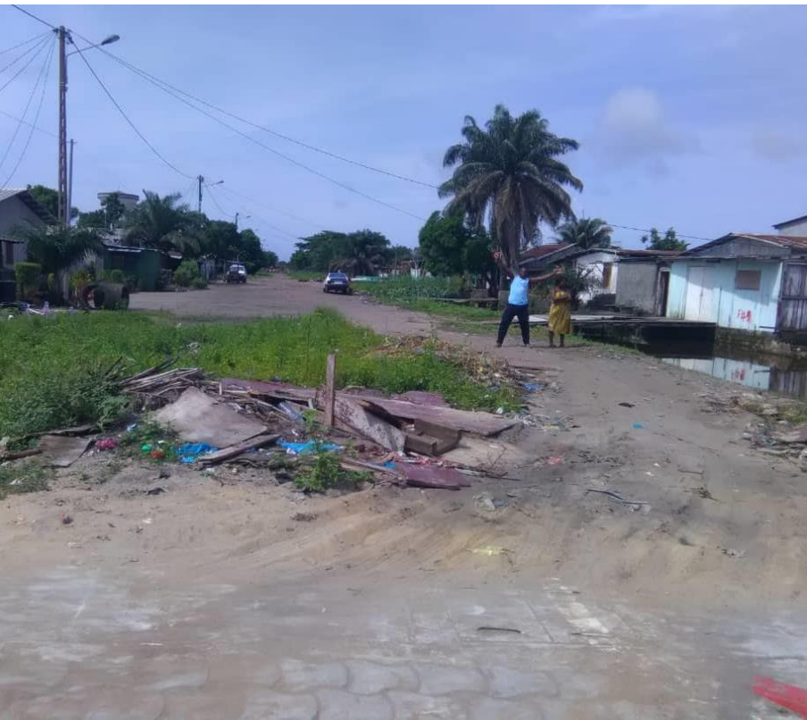
Etat des lieux avant Travaux
