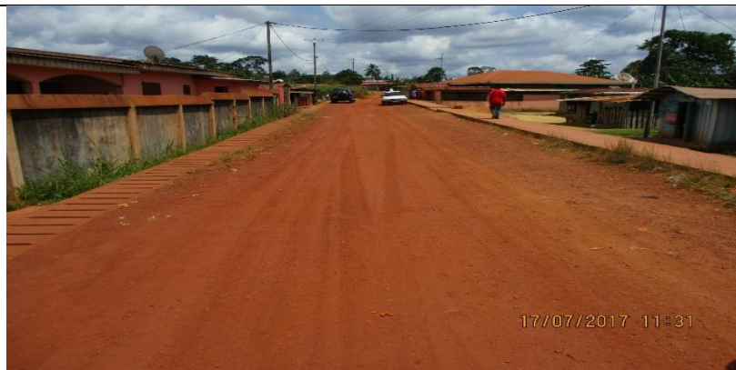
Etat des lieux avant travaux
