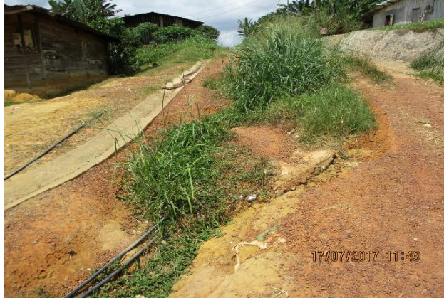
Etat des lieux avant travaux
