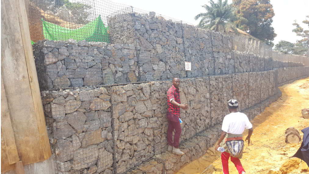
Lutte anti-érosive à la côte : Construction d'un mur en gabions.
