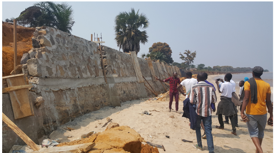
Lutte anti-érosive à la côte : Construction d'un mur en maçonnerie
