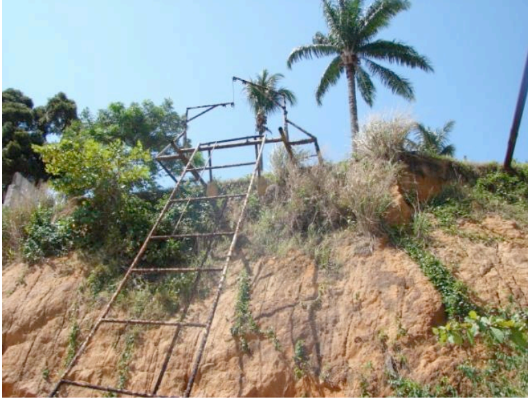
A gauche, pylône de courant tombé à cause de l'érosion, et à droite, paillette en construction à la plage Tonde (déforestation).
