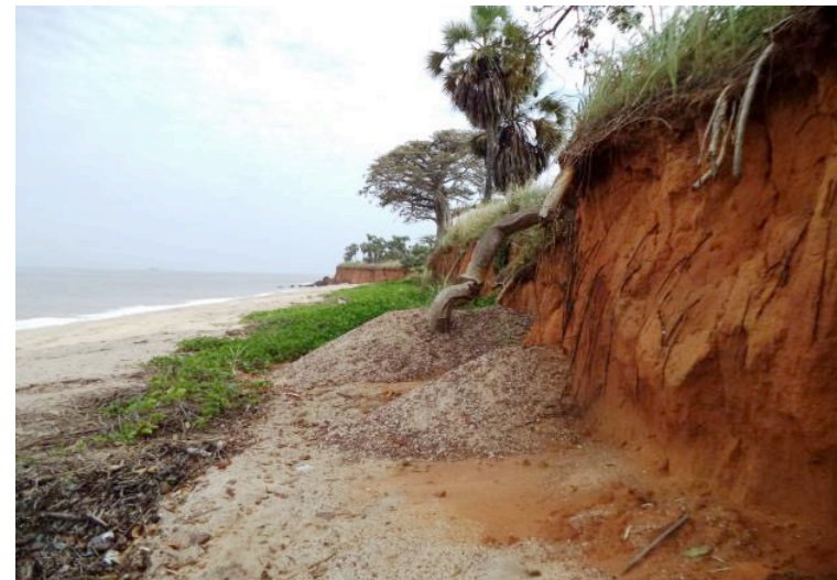
Bâtiment colonial à Nsiamfumu affecté par l'érosion (à gauche) et Extraction de graviers aux pieds des falaises à Nsiamfumu (à droite)
