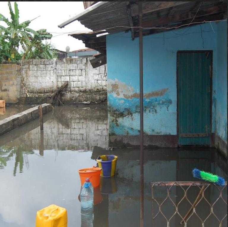
Inondation des maisons
